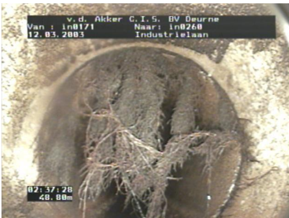
Afbeelding 4: door wortelingroei neemt de weerstand en hiermee de kans op wateroverlast toe
