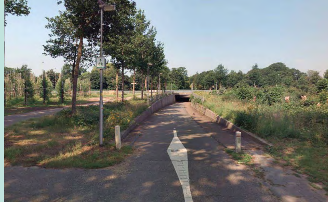
► Fietstunnel (referentie N781)
