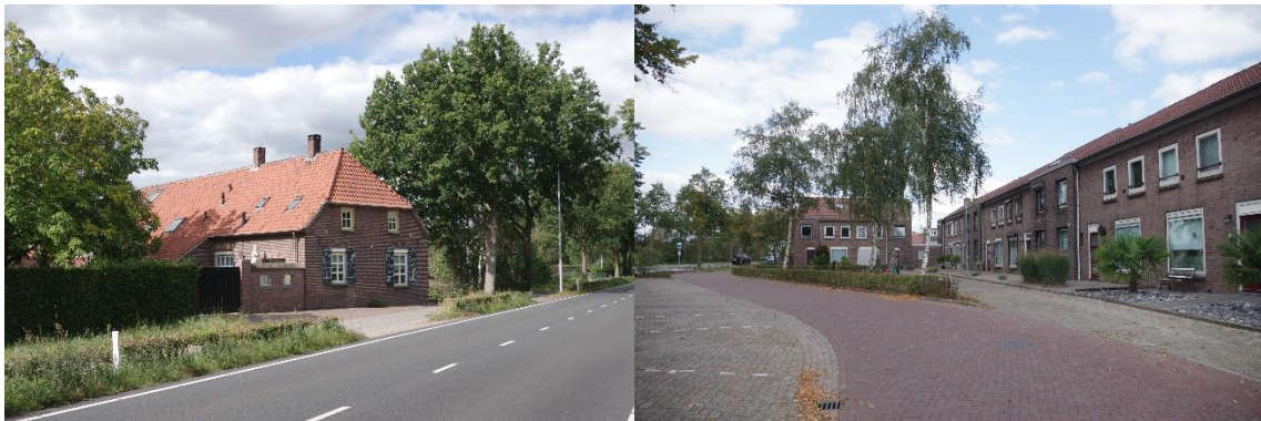
Afbeelding 4.11 Gebouwen met potentiële gelegenheden voor verblijfplaatsen van gebouw bewonende vleermuizen bij variant B
