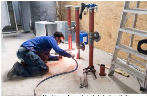
Mooi laswerk aan de technische installatie
