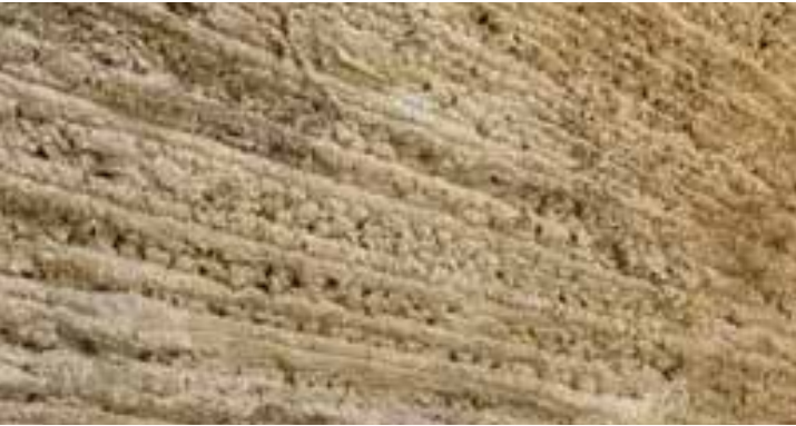
AE5 TALUD WAND
