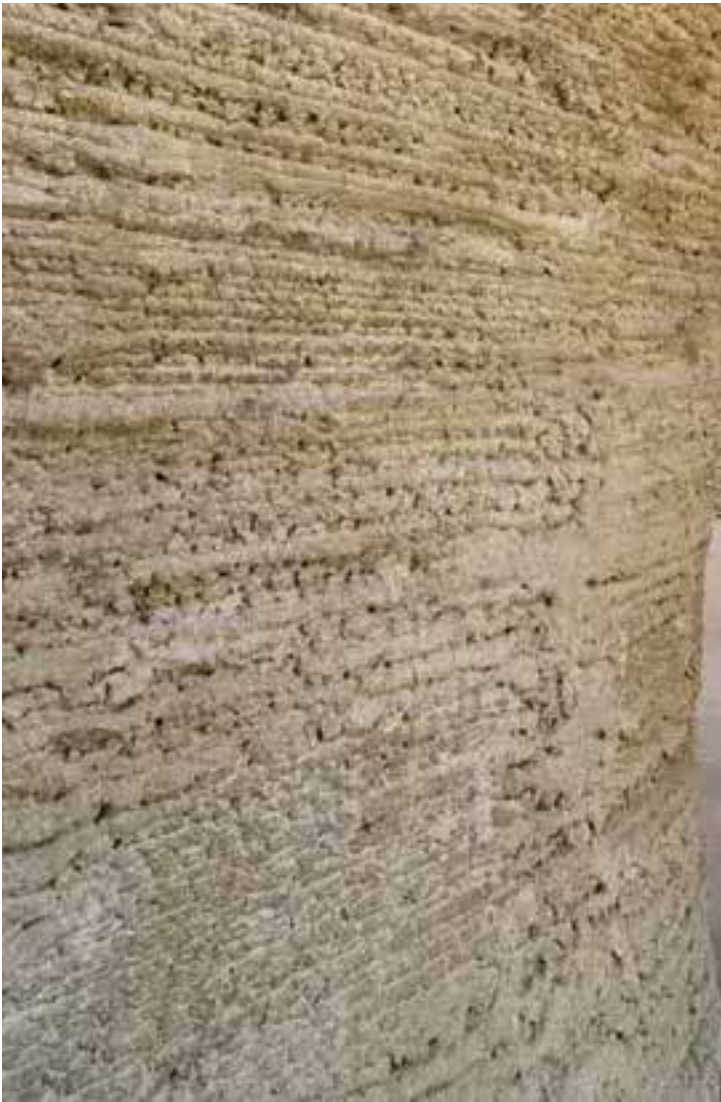
AE5 TALUD WAND
