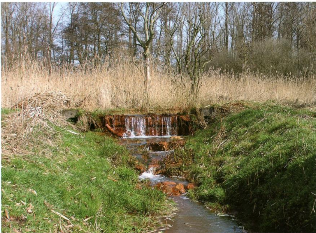
Afbeelding 8: Neerslag van ijzer in een ontwateringssloot op de breuktrede. De stuw/sluis remt de afwatering om verdere verdroging van de wijstgronden te voorkomen. Het water is roestbruin door het wijstwater (uit Van Balen, 2009)
