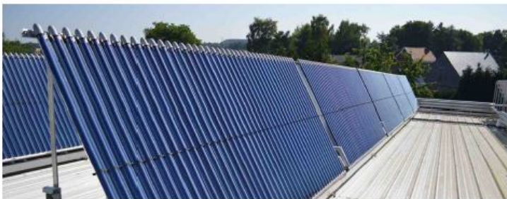
ZONNECOLLECTOREN VOOR OPVANGEN VAN ZONNEWARMTE. COLLECTOREN AANSLUITEN OP HET WATERBASSIN OM ZODOENDE WARMTE OP TE SLAGEN VOOR DE WINTER.
